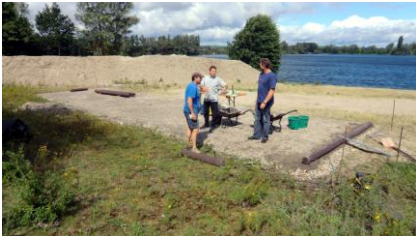
Juli 2012, 10.00 Uhr Bauphase 2: Die Umrandung aus Kunststoffbalken wird angebracht
