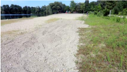
Juni 2012 Bauphase 1: Schotter aufbringen
